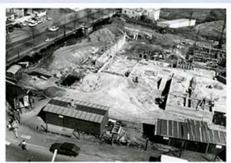
Fotos vom Baubeginn des Egerland-Kulturhauses Ende 1970
